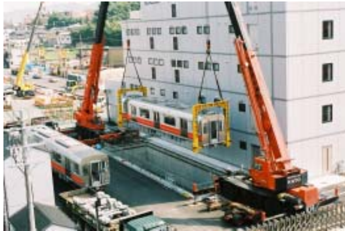
電車の出し入れ状況
