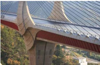
斜めケーブル定着部と波型鋼板ウェブ。橋の南側（写真の右下）では、大戸川ダム事業に伴う付替県道の工事も実施されていました。
