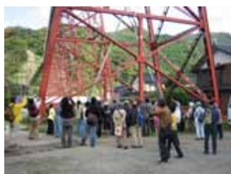
余部鉄橋下で第1班が説明を受けて橋を見上げています。
