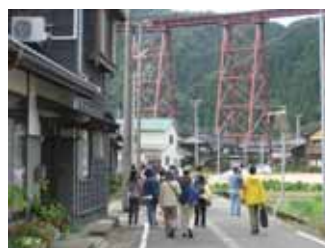
もうすぐ余部鉄橋に第1班が到着します。
