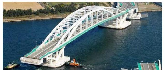
写真2 旋回中の浮体橋(夢舞大橋)
