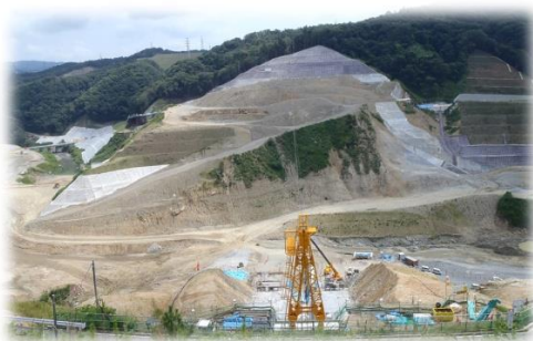
安威川ダム(建設中)
