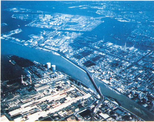
阪神高速道路湾岸線(南港北～三宝)
