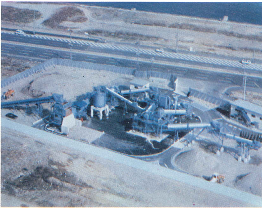
大阪市掘削残土処理プラント
