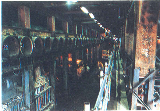
大口径パイプルーフによる仮受け
