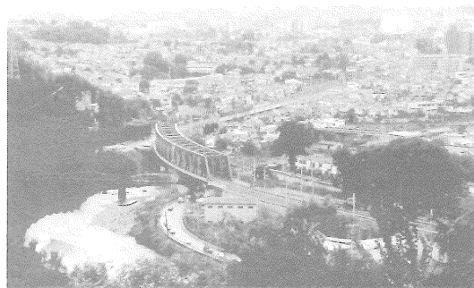
第1武庫川橋梁(L=150m) (曲線連続道床式下路トラス)
