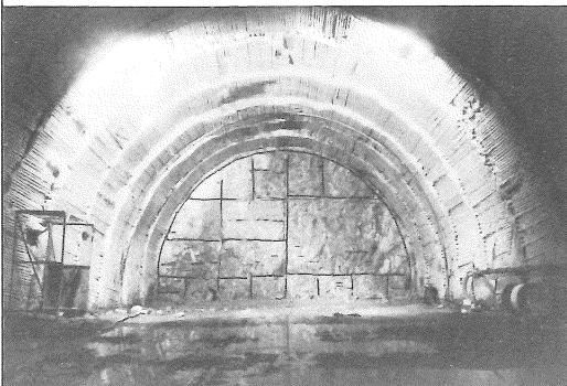
スロット削孔機による掘削完了状況
