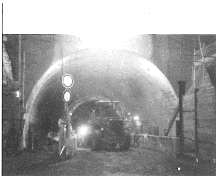
既設トンネル取りこわし状況(夜間通行止)
