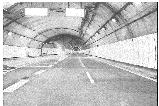
分岐部完成状況
