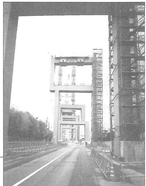
魚崎高架橋基礎工事
