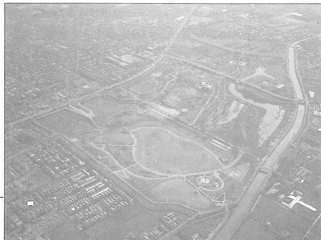
寝屋川遊水池全景
