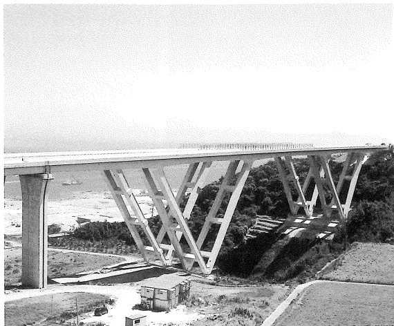
■灘川橋（V脚ラーメン橋）
