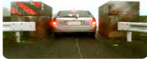
石樽峠 大型車の進入を規制する、巨大なコンクリートブロック
