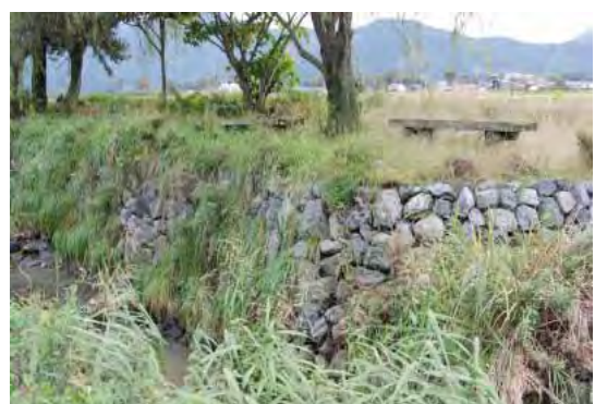
生態系配慮型水路の空石積み護岸 （2010.11 撮影）
