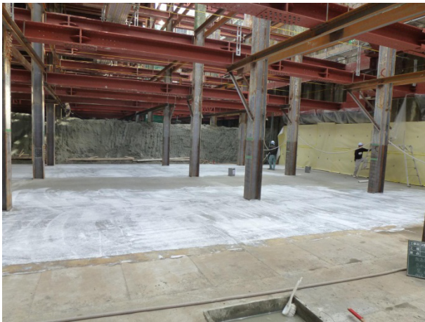
開削トンネル工事
