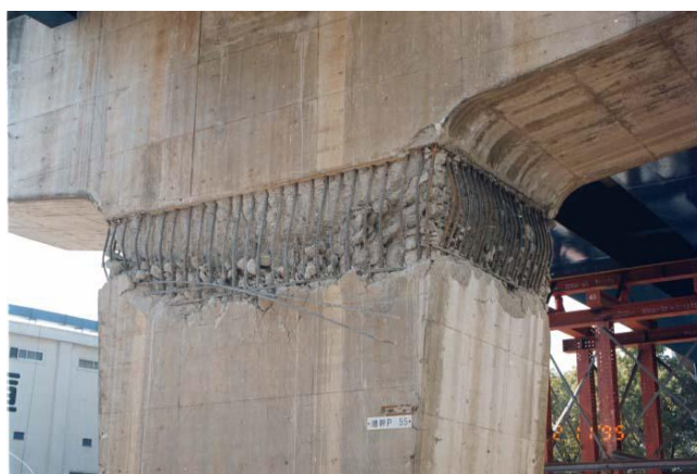
写真 2 鉄筋コンクリート橋脚の破壊例
