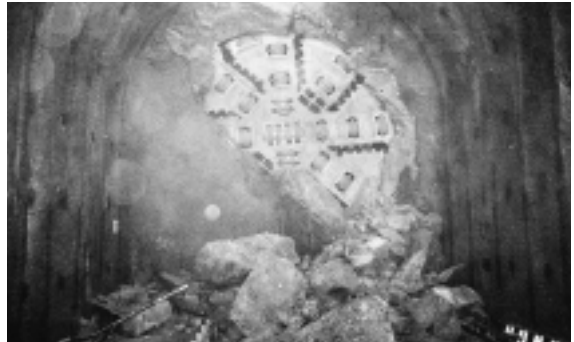
Haagの建設現場にて
